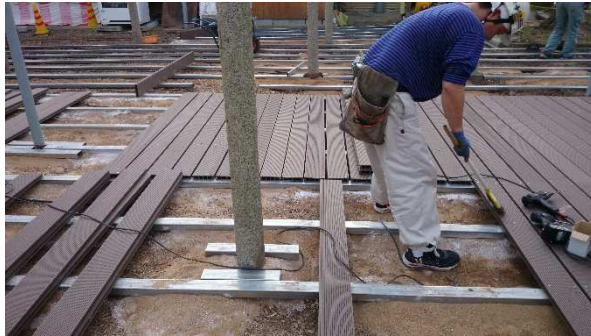
(写真-1) 平成 28 年 4 月 スノコを木製から樹脂製に替える
